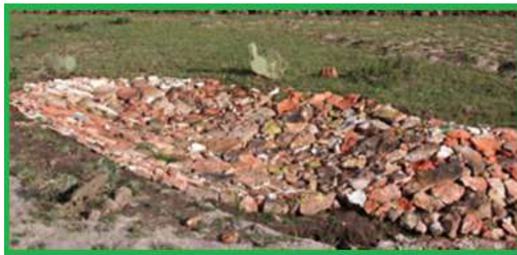
Fig. 9. Cabeceo de una cárcava
