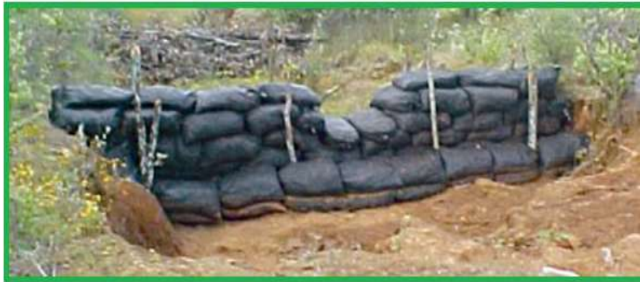
Fig. 27. Imagen de una presa de geocostal.
